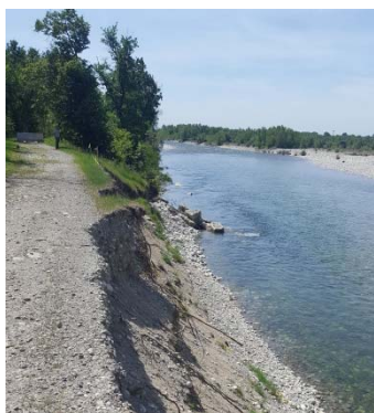
Erosione argine a seguito eventi alluvionale del 21-25 novembre 2016
