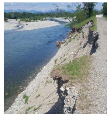
Erosione argine a seguito eventi alluvionale del 21-25 novembre 2016
