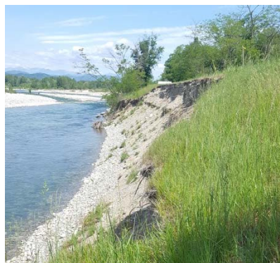
Erosione argine a seguito eventi alluvionale del 21-25 novembre 2016
